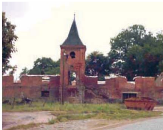
Der Kornspeicher vor der Restaurierung
